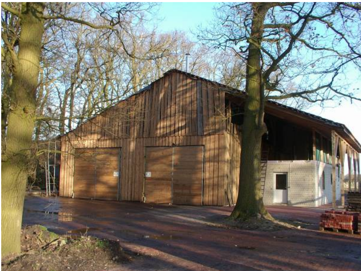
Abbildung 2: Foto Biogasanlage Front mit Fermentertoren
