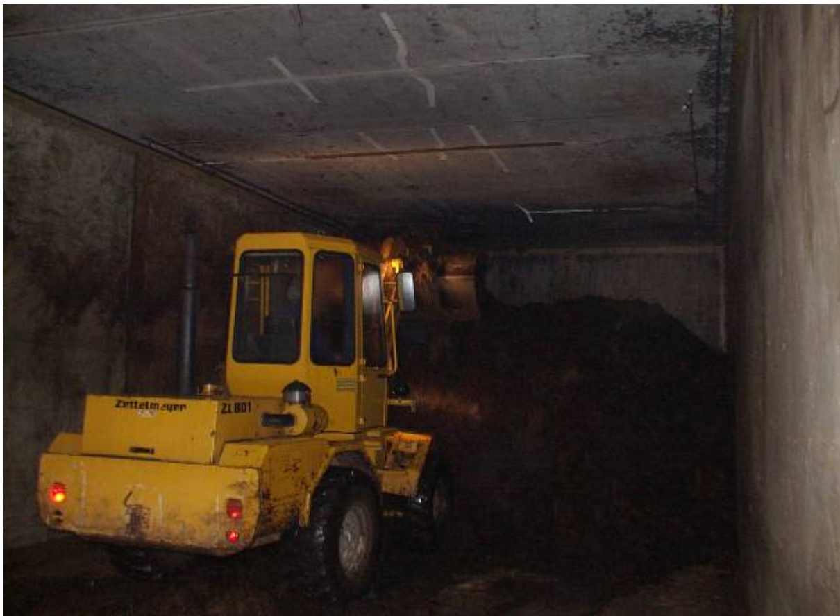
Abbildung 7: Innenraum des Fermenters beim Befüllen
