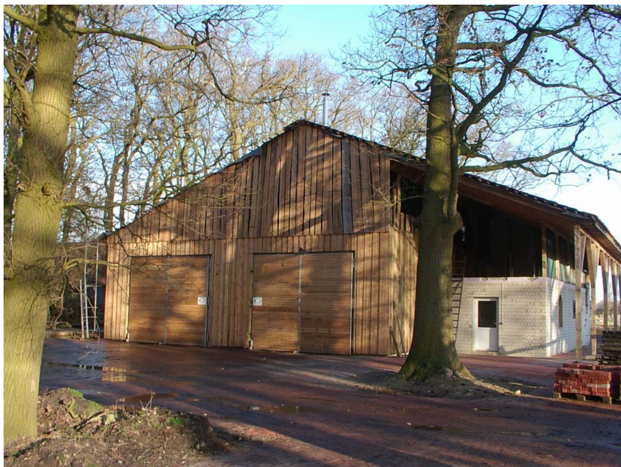
Abbildung 2: Foto Biogasanlage Front mit Fermentertoren
